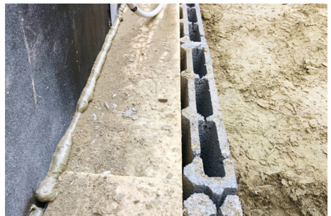
Abb. 1 Filter-Sickerplatte vor Perimeterdämmung.
