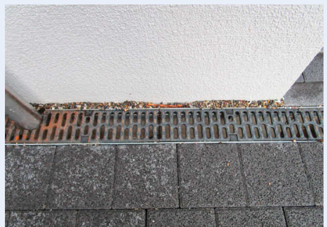
Bild oben: Entwässerungsrinne und Flachstahl roh, Asphaltbelag.
