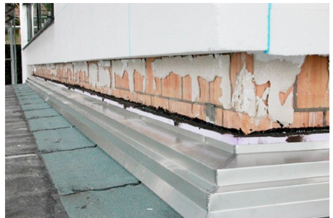
Abb. 9 Putzstreifen bei der Sanierung eines Sockelbereiches (Anschluss der VAWD an Flachdach).
