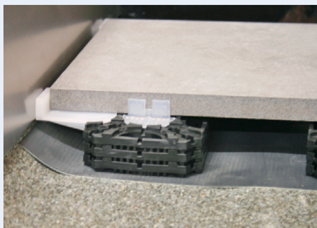
Offene Fuge zur Fassade mit Distanzhalter.
