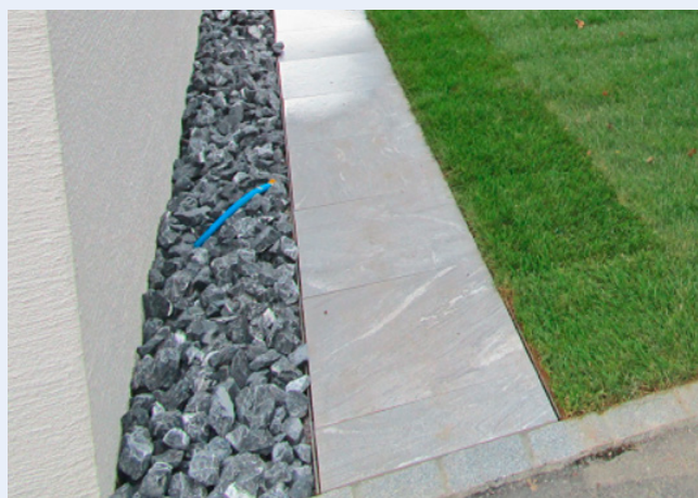
Bild oben: Rundkies Korngrösse 32/64 mm, Randabschluss 20 cm.
