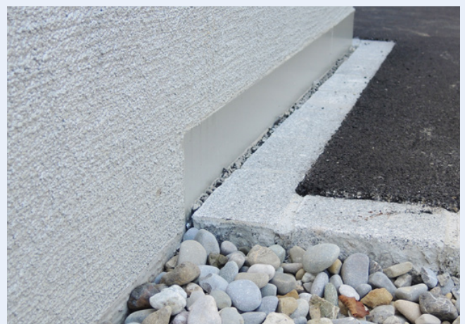
Bild oben: Bundstein in Beton versetzt, Asphaltbelag.
