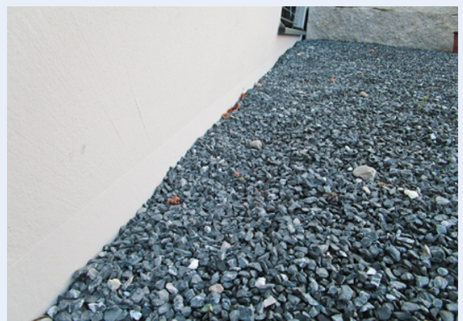
Bild oben: Abschalung der wassergebundenen Schicht als Fassadenschutz für den Einbau.
