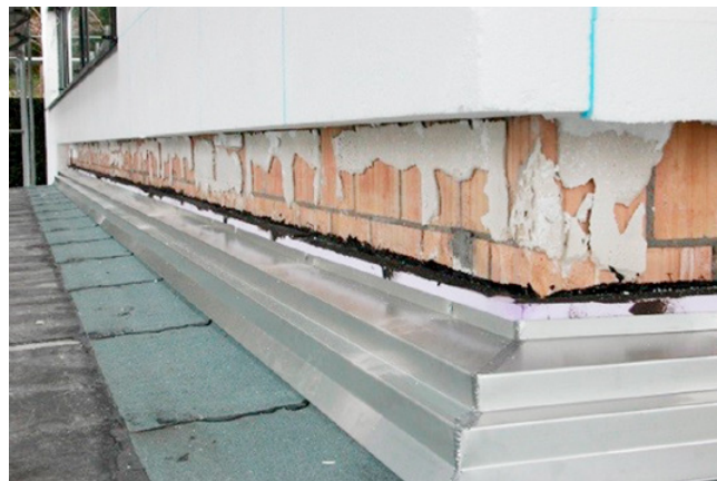
Fig. 9 Bande de solin posée dans le cadre de l'assainissement d'un soubassement (raccord de l'ITEC au toit plat).
