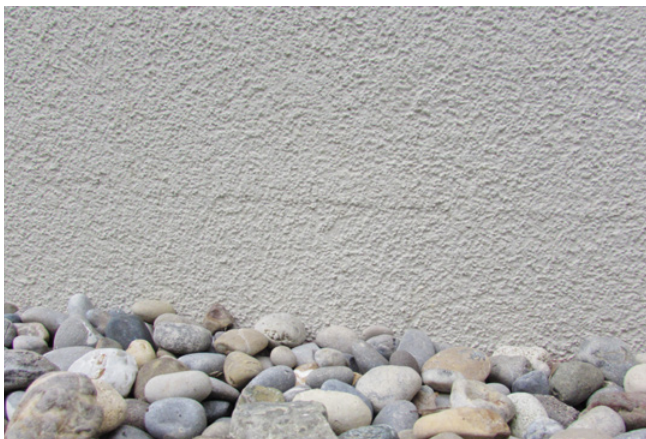
Fig. 2 Marque d'irrégularité signalant une transition entre panneaux isolants de soubassement et panneaux isolants de façade
