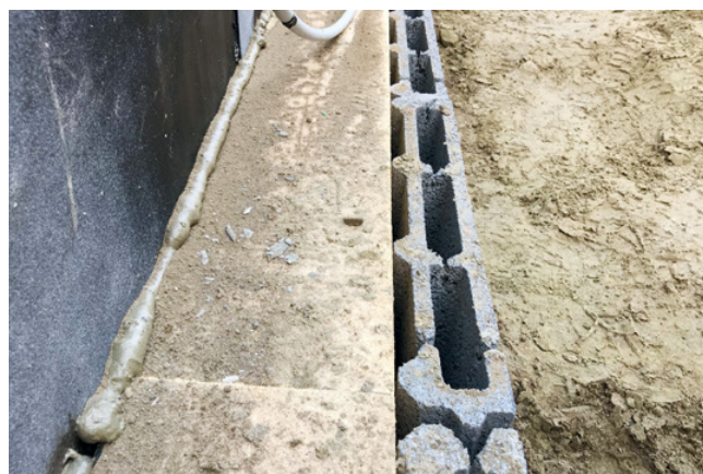
Fig. 1 Plaques filtrantes montées devant l'isolation périphérique.
