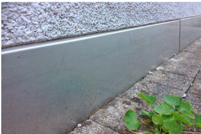
Fig. 8 Blindage de soubassement.
