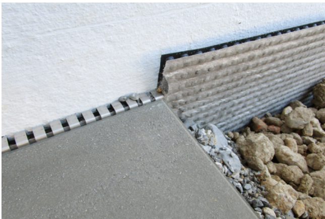
Fig. 7 Joint exécuté avec un profilé perméable à l'air (ajouré), en acier inoxydable.
