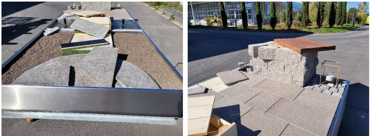
3. Répartir du gravier sur la tôle perforée du bassin d'eau et lester les lampes subaquatiques avec du gravier. Remplir le bassin d'eau et brancher l'électricité pour faire fonctionner les lampes et les pompes.
