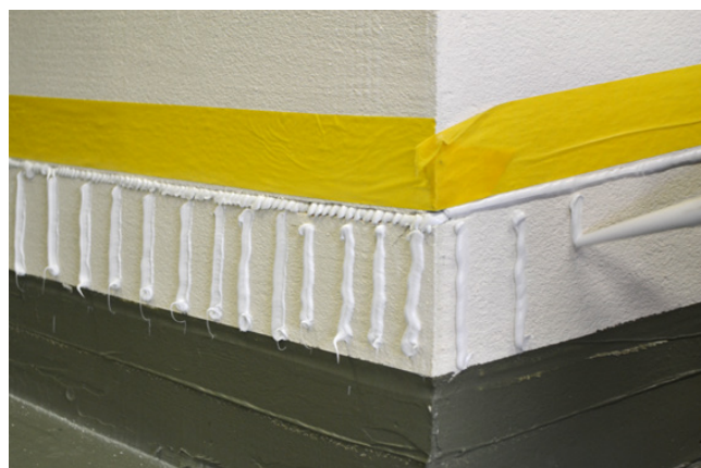
Fig. 11 Applicazione verticale dell'adesivo per montare la lamiera di protezione dello zoccolo.
