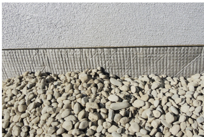
Fig. 6 Stuoia di drenaggio resistente alla compressione quale protezione meccanica della facciata (non tessuto rivolto verso l'esterno) durante lo riempimento con ghiaia tonda.
