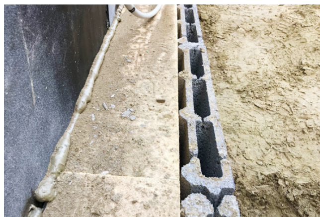
Fig. 1 Pannello filtrante/drenante davanti all'isolamento perimetrale.
