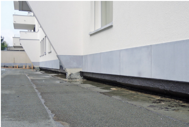
Fig. 3 Protezione dagli spruzzi mediante elementi di zoccolatura.
