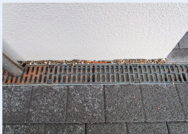
Foto sopra: canale di drenaggio e acciaio piatto grezzo, copertura in asfalto.
