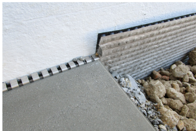
Fig. 7 Posa in opera del giunto con un profilo permeabile all'aria (intagliato) in acciaio inossidabile.
