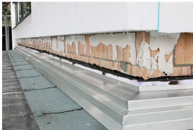
Fig. 9 Copertina in caso di risanamento di uno zoccolo (raccordo dell'isolamento termico esterno a cappotto alla facciata).
