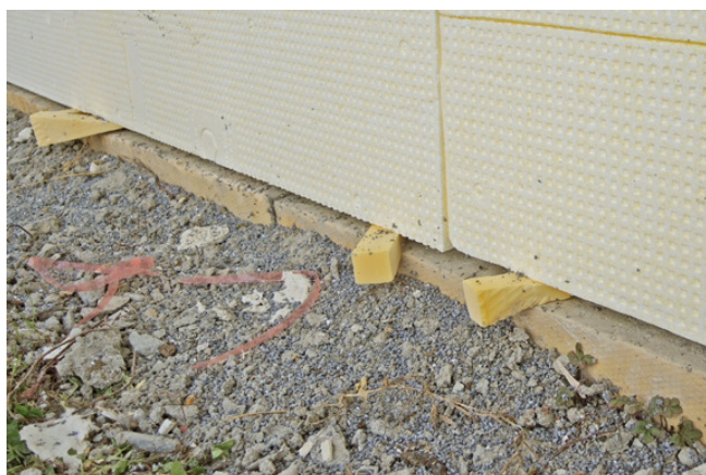
Fig. 10 Raccordo del pannello isolante dello zoccolo all'isolamento perimetrale sul lato della costruzione. Questo dettaglio eseguito in modo scorretto (giunto aperto) crea un ponte termico nell'isolamento termico a cappotto.
